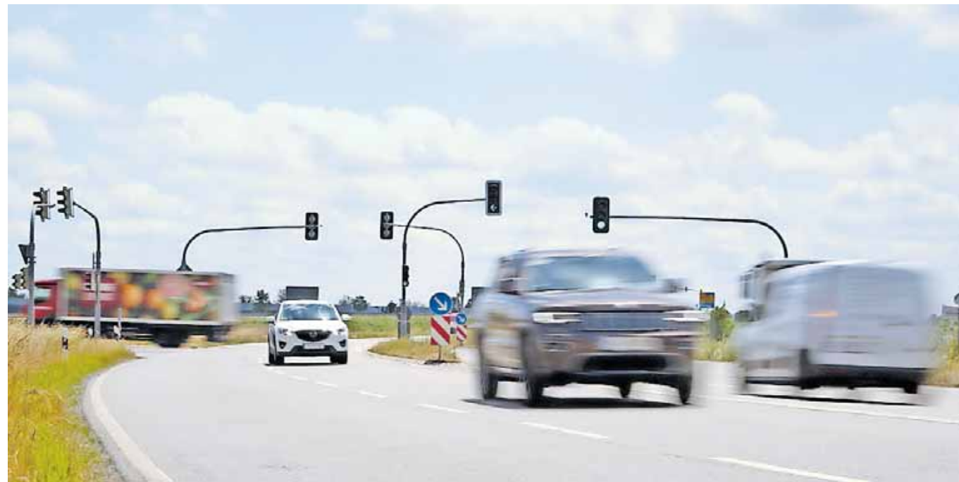
Nach der A9 wird auch die B471 in Garching zur Teststrecke für das Providentia-Projekt. FOTO: ROBERT HAAS
