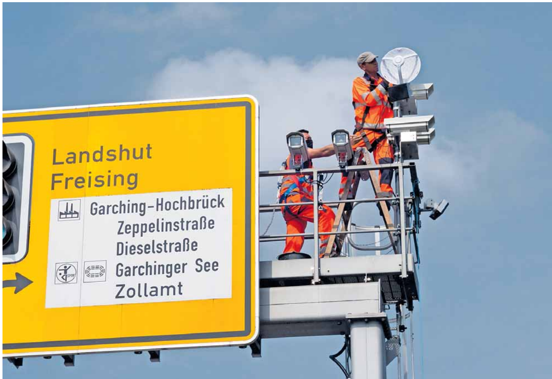
Mit Kameras, Radar- und Lidargeräten auf den Schilderbrücken wird der Verkehr erfasst. Mit den gesammelten Daten wird ein „digitaler Zwilling“ erstellt, um so Staus und gefährliche Situationen vorhersagen zu können. FOTO: TU MÜNCHEN
